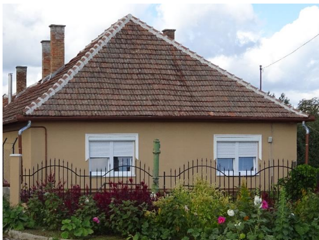
Egyszerű homlokzat, keretezett nyílászáróval
