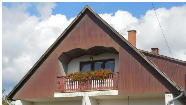
Az erkély homlokzatburkolatának egyedi kialakítása igazán karakteressé teszi az épületet.
